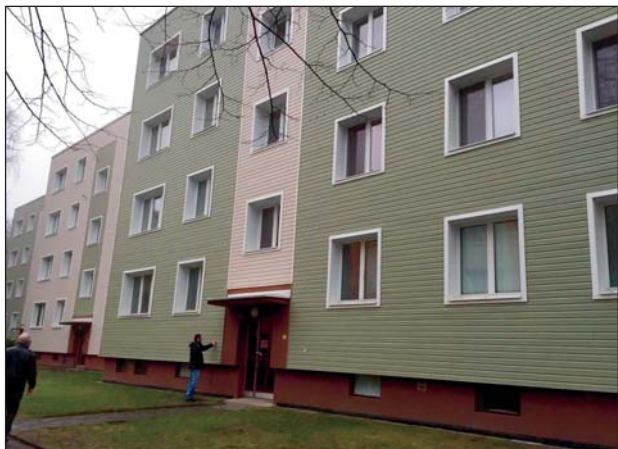
PŘÍKLAD ZE STUDÉNKY, jak může bytový dům po realizaci zateplení vypadat.
