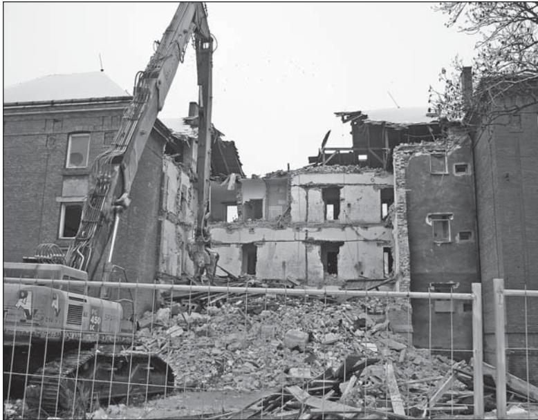
DNE 9. LEDNA zahájila společnost DAV, a. s., demolici domu.
