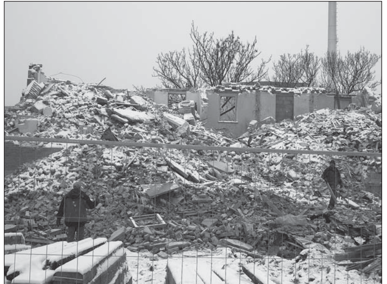
POMÁHALA těžká technika, ale stavební materiál třídili pracovníci vlastníma rukama.
